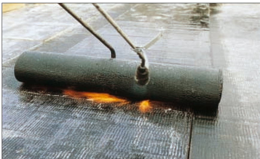
Soudage à la flamme de la membrane d'étanchéité, réalisé directement sur le panneau ROCK UP B SOUDABLE.
