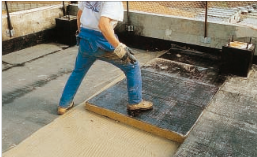
Facilité de pose du panneau ROCK UP B SOUDABLE par collage, à l'aide de FIX UP 284.
