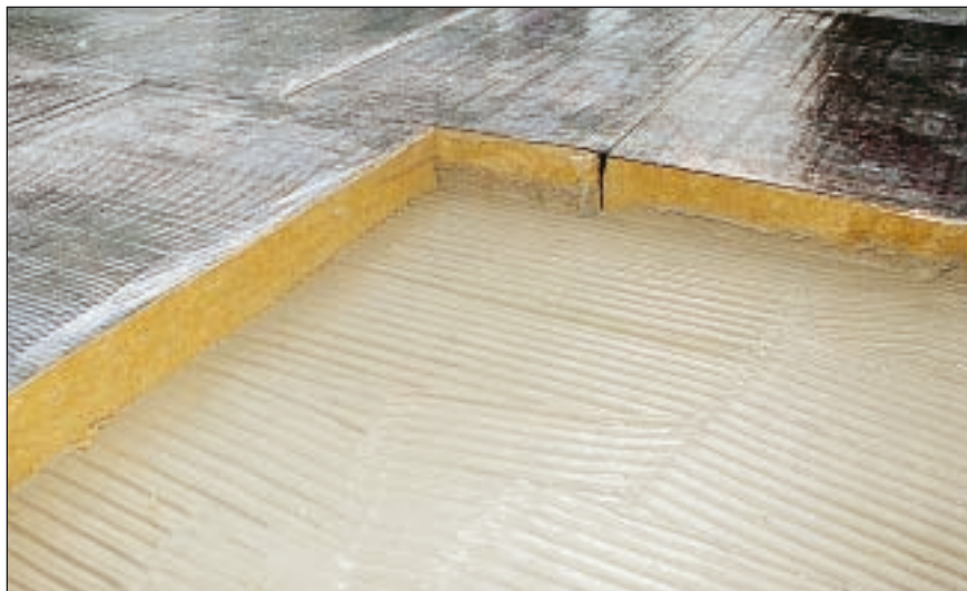
FIX UP 284, étalé à l'aide d'une raclette crantée, assure l'adhérence totale du panneau ROCK UP B SOUDABLE au support.
