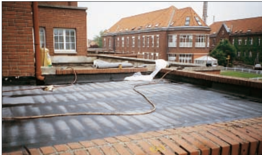
Perspective de la toiture isolée et étanchée.
